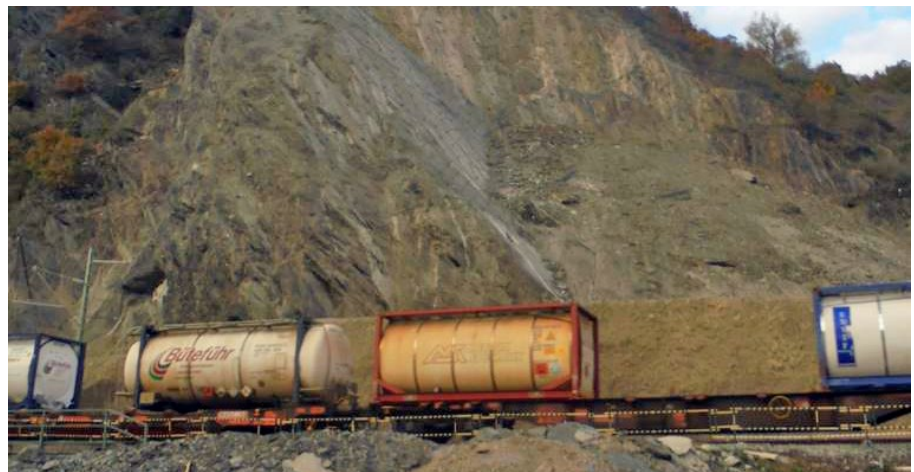
1: Güterzug vor dem Felssturz in der Nähe von Kestert im Mittelrheintal
